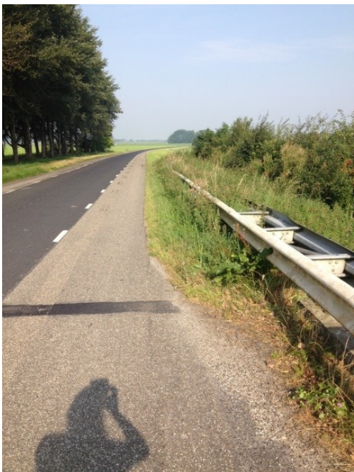
vangrail in berm = zeer lastig bermonderhoud
