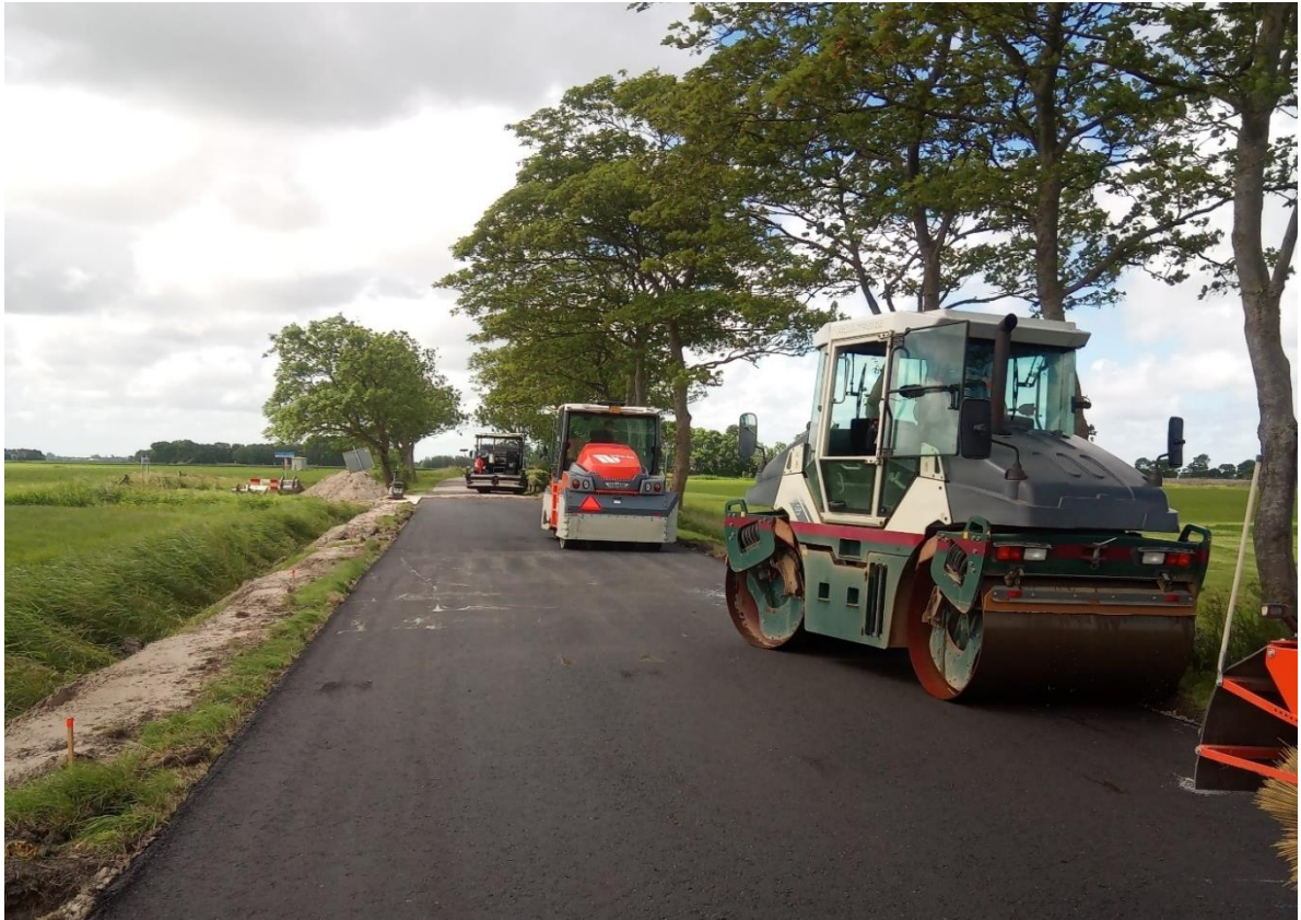
Asfalteringswerkzaamheden in de gemeente Waadhoeke
