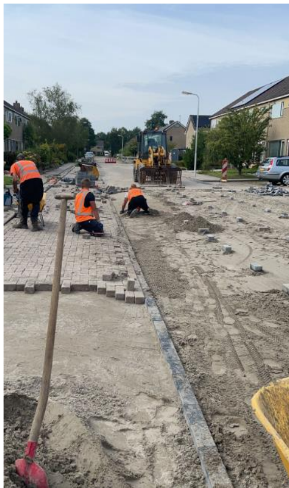
Bestratingswerkzaamheden in de gemeente Waadhoeke
