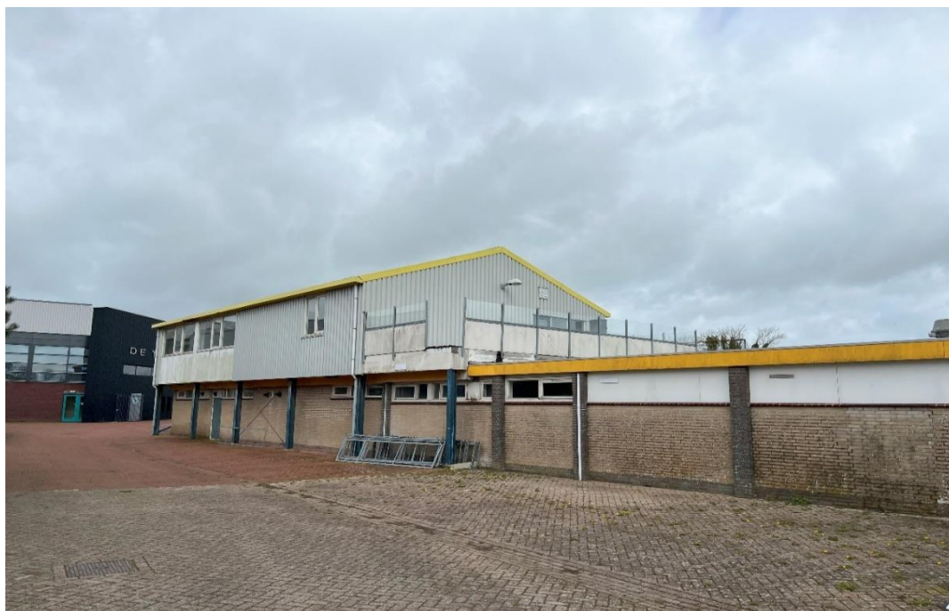
De contour van het gebouw blijft intact door hergebruik van de stalen spanten, fundering en vloeren.
