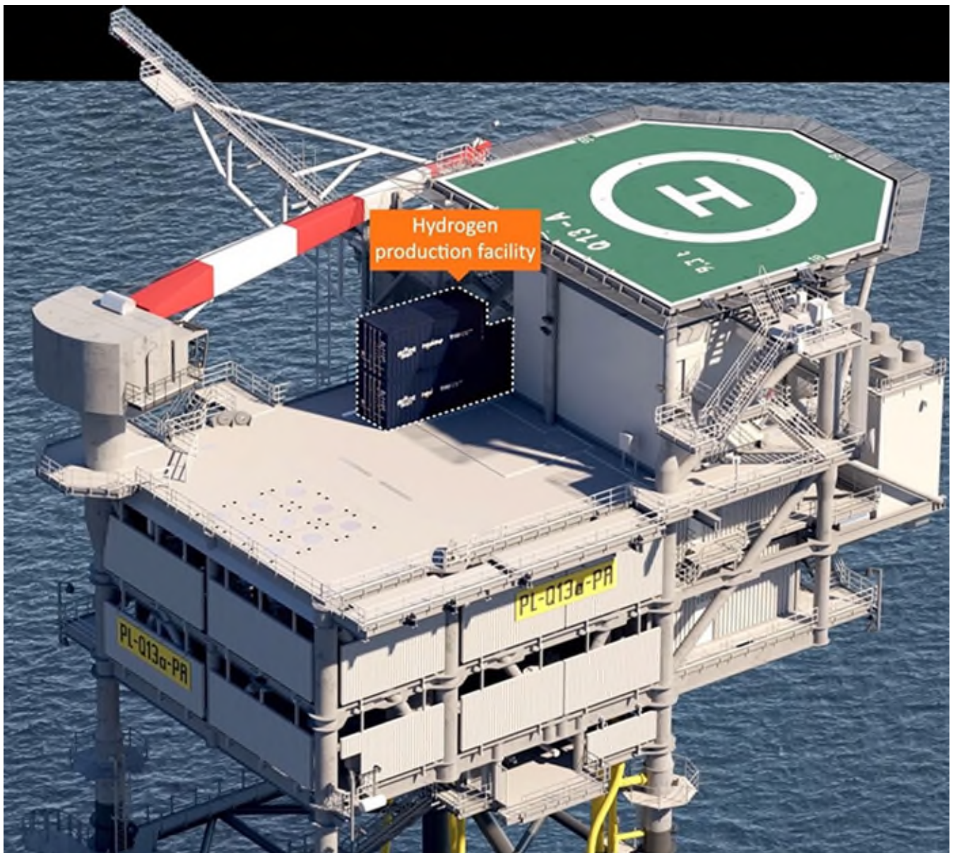
PosHYdon installatie: groene waterstof uit zeewater.
