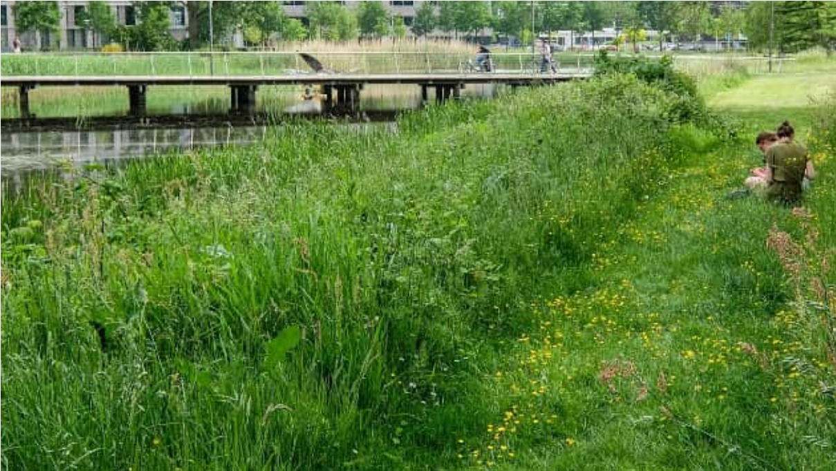
Waterlopen hebben flauwe taluds voor een natuurlijke uitstraling.
