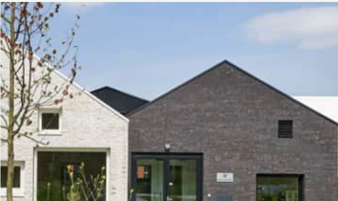
Dak gedetailleerd met een minimale dakrand.
