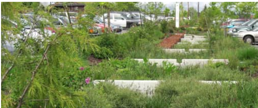
Tussen parkeerplaatsen is ruimte voor groen en waterinfiltratie.
