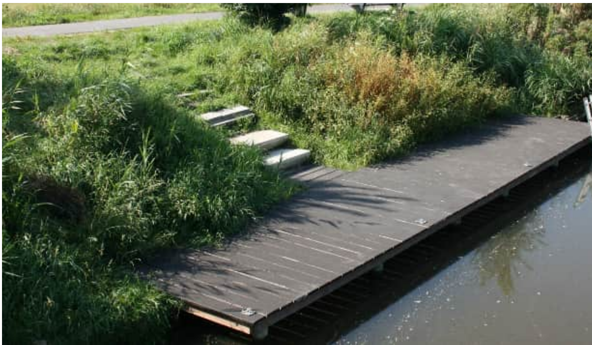
Steiger als verblijfs- en opstapleplek voor waterrecreatie.
