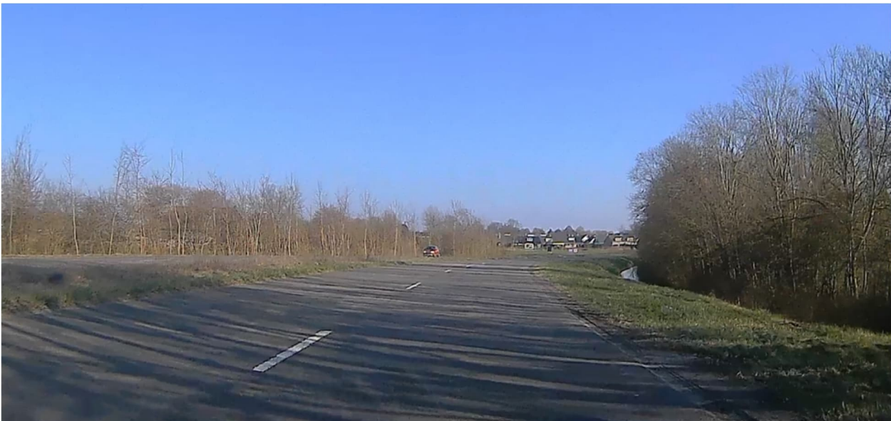
Figuur 7: Het ruime profiel van de rondweg, foto genomen tijdens verkeersveiligheidsaudit.
